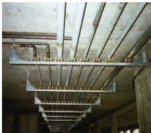
Сурет 2. Каналдарды компенсациялық роликтерде бекіту.
