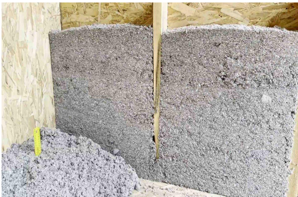
Сурет 2. Модульдік ғимараттың экологиялық қауіпсіздігі үшін қолданылатын экоматта материалы.
