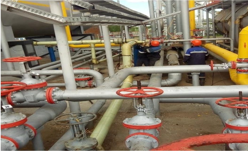
Сурет 3. Өзен кен орнында жинау жүйесінде ШТҚ монтаждау.
